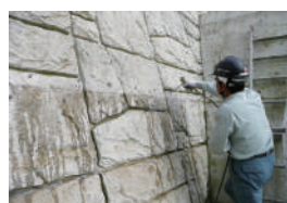
【砂防ダム 水平打継ぎ】
