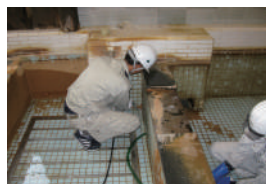
【上階 浴場内浴槽】
