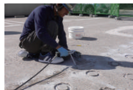
【店舗屋上 駐車場打継ぎ】
