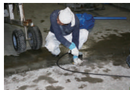
【地下 床板打継ぎ】
