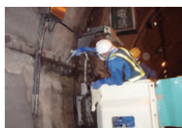
【国道 トンネル内打継ぎ】
