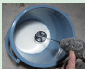
グリーンシール主材・B材の混合溶液 〔ケイ酸ナトリウム & 水酸化カルシウム〕
