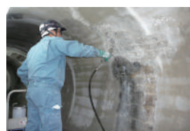
【ダム底 管廊トンネル】
