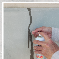
【ゲルボン注入】
