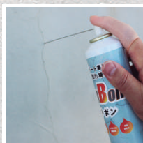
【ゲルボン注入】
